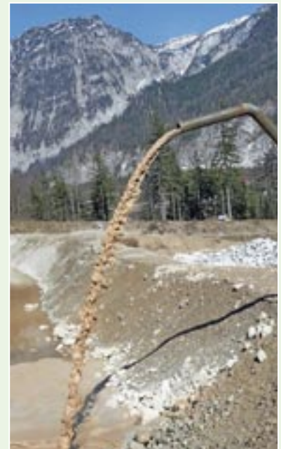
Einleitung in den Schlammteich
